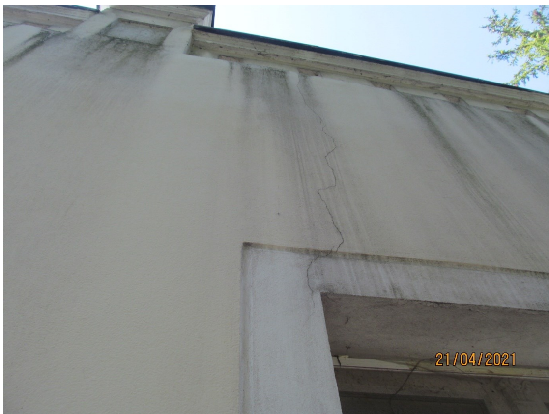
Zdj. 5.10 Zarysowanie ściany zewnętrznej w rejonie nadproża
