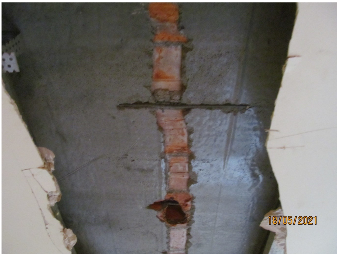
Zdj. 5.15 Odkrywka 4, widoczne zbrojenie prętami Ø6 żeberka i niskiej części płyty (w warstwie zaprawy, poniżej płyty ceglanej)
