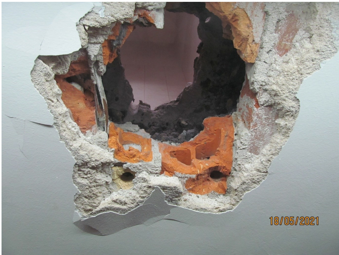
Zdj.5.12 Odkrywka stropowa 1, widoczne zbrojenie z bednarki
