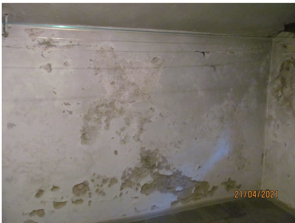
Zdj. 5.2 Zawilgocone i odpadające tynki w piwnicy
