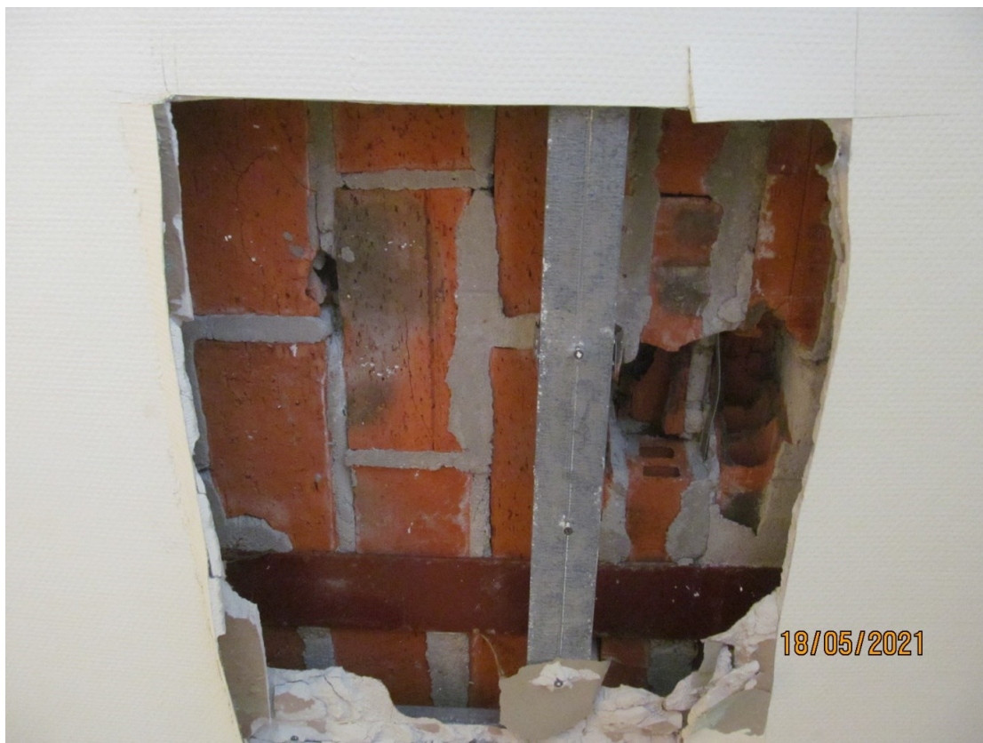
Zdj. 5.13 Odkrywka 2/3, widoczne zbrojenie żeberka z bednarki i belka
