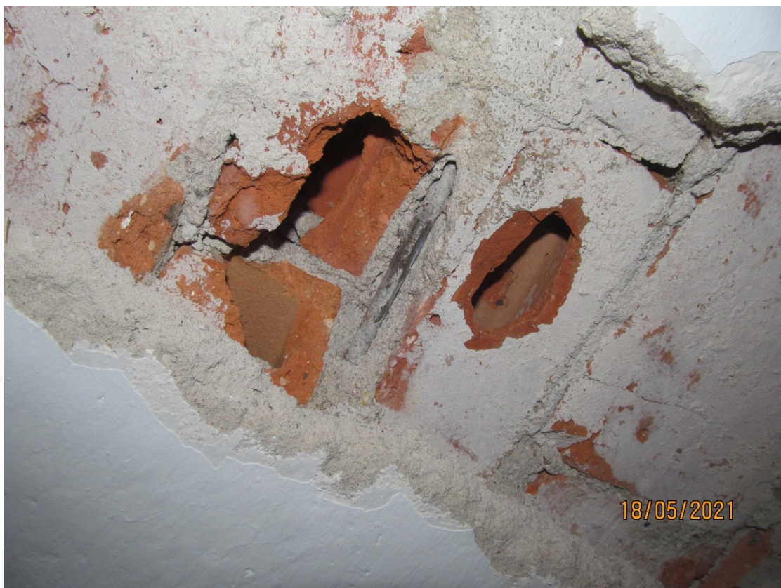
Zdj. 5.17 Odkrywka 5, widoczne zbrojenie prętami Ø6 żeberka
