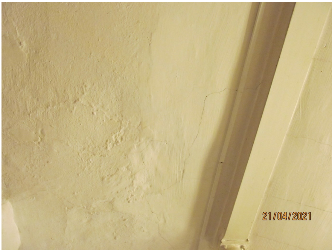
Zdj. 5.11 Zarysowania sklepienia odcinkowego w pomieszczeniu z konstrukcją stalową
