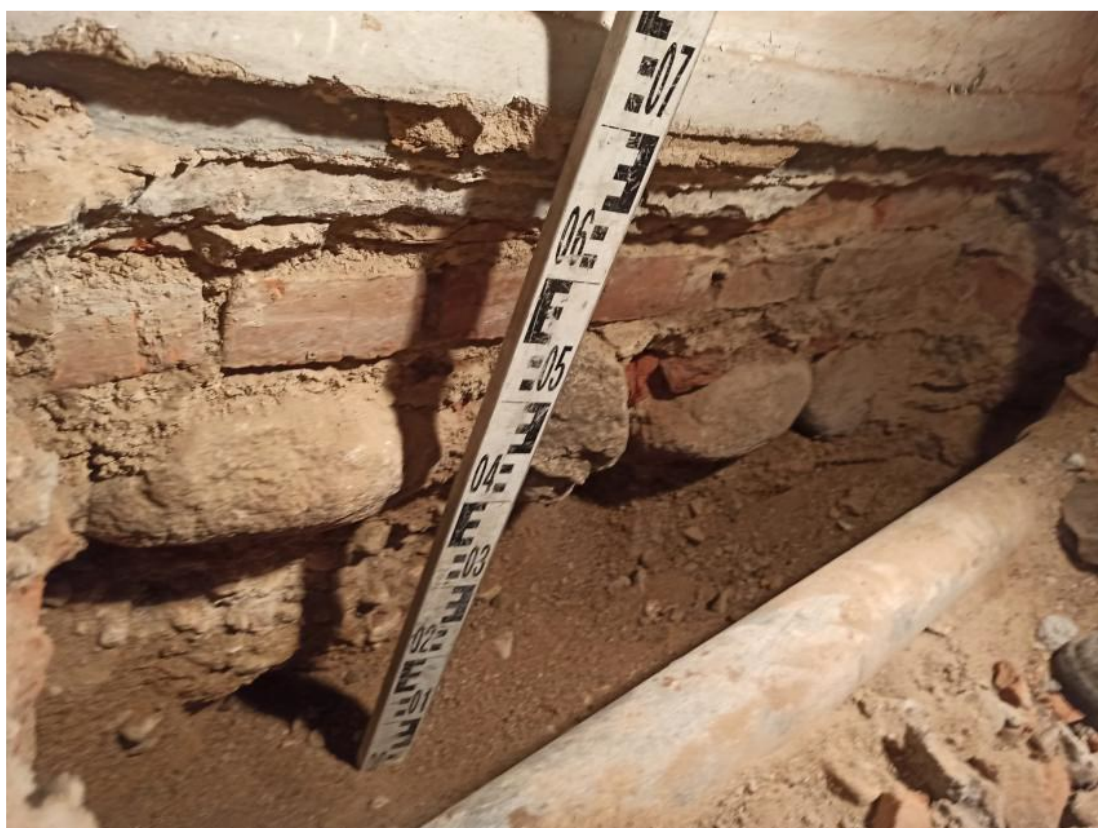
Zdj. 5.6 Odkrywka fundamentowa ściany wewnętrznej w części podpiwniczonej
