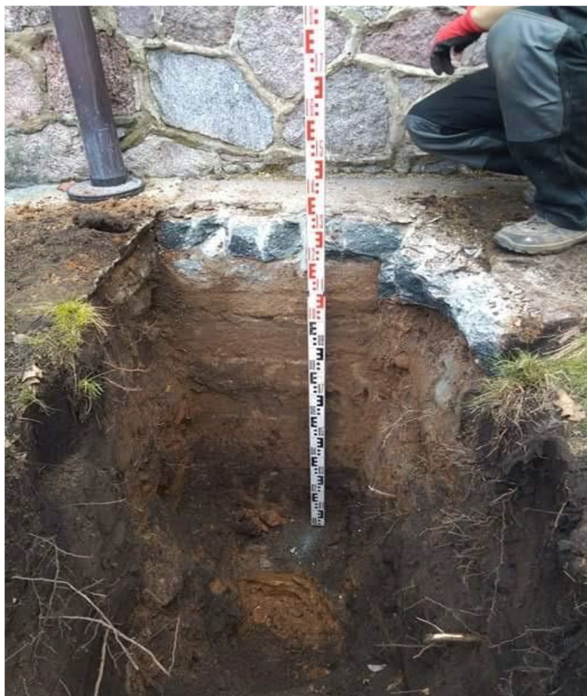
Zdj. 5.5 Odkrywka fundamentowa ściany zewnętrznej części niepodpiwniczonej
