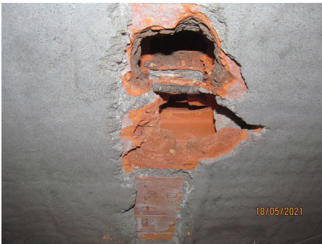
Zdj.5.16 Odkrywka 4, widoczne zbrojenie prętami Ø6 żeberka
