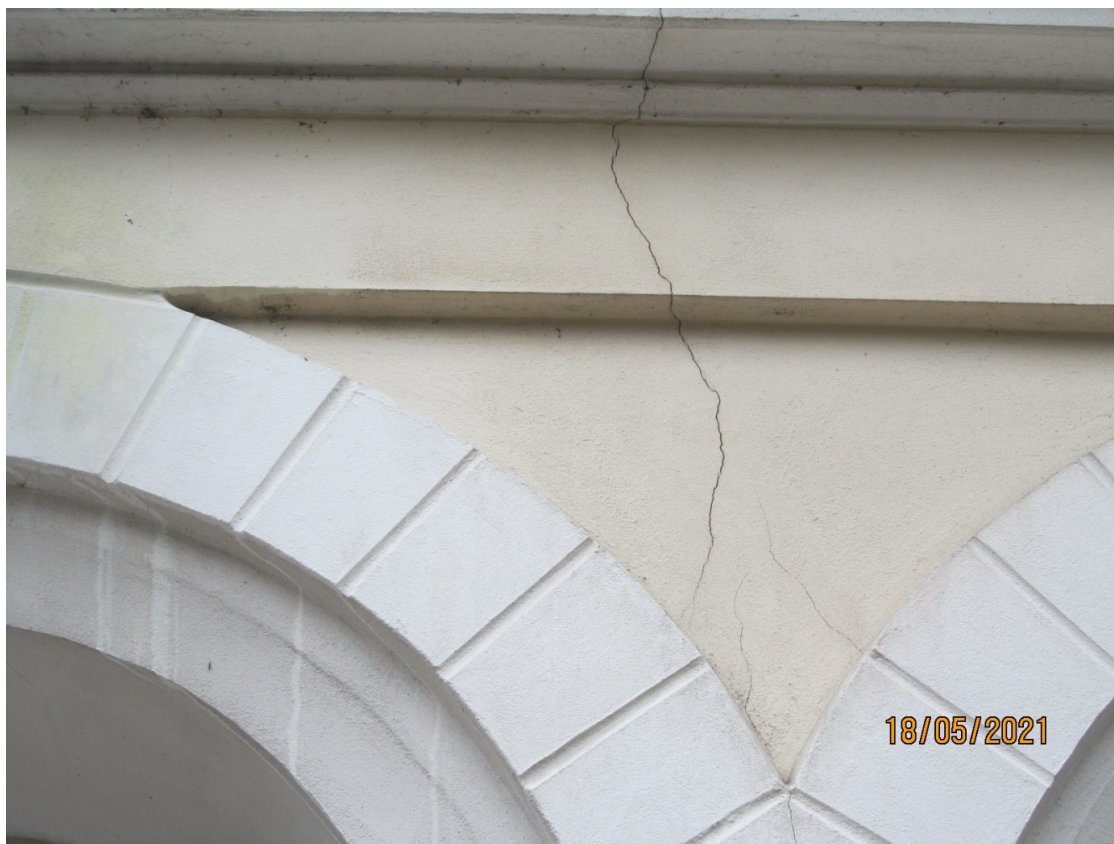
Zdj. 5.9 Zarysowanie muru w części ryzalitowej
