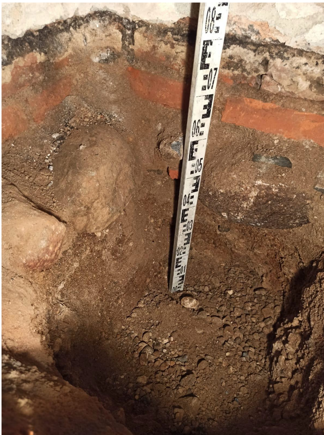
Zdj. 5.7 Odkrywka fundamentowa ściany wewnętrznej w części podpiwniczonej
