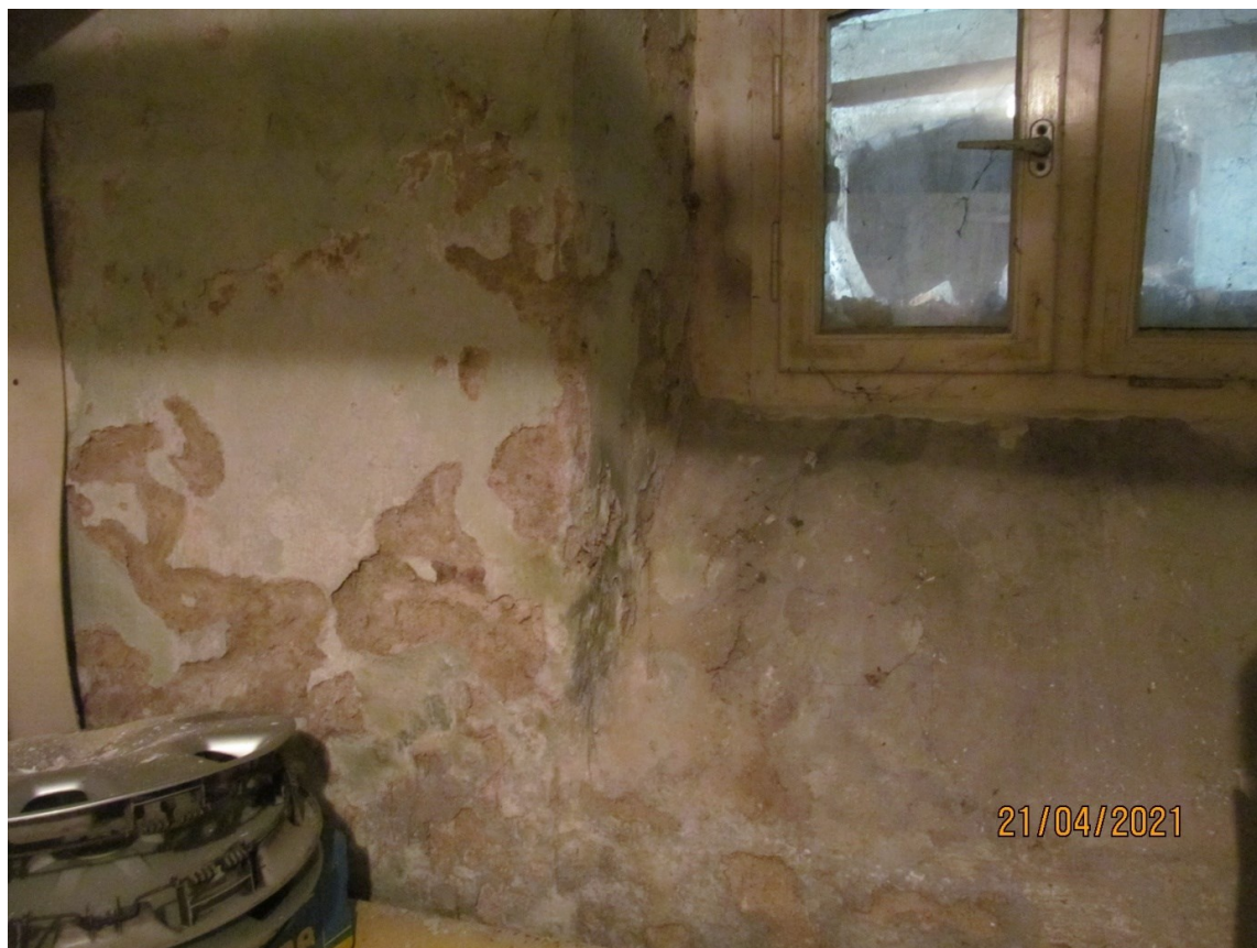
Zdj. 5.3 Zawilgocone i odpadające tynki w piwnicy
