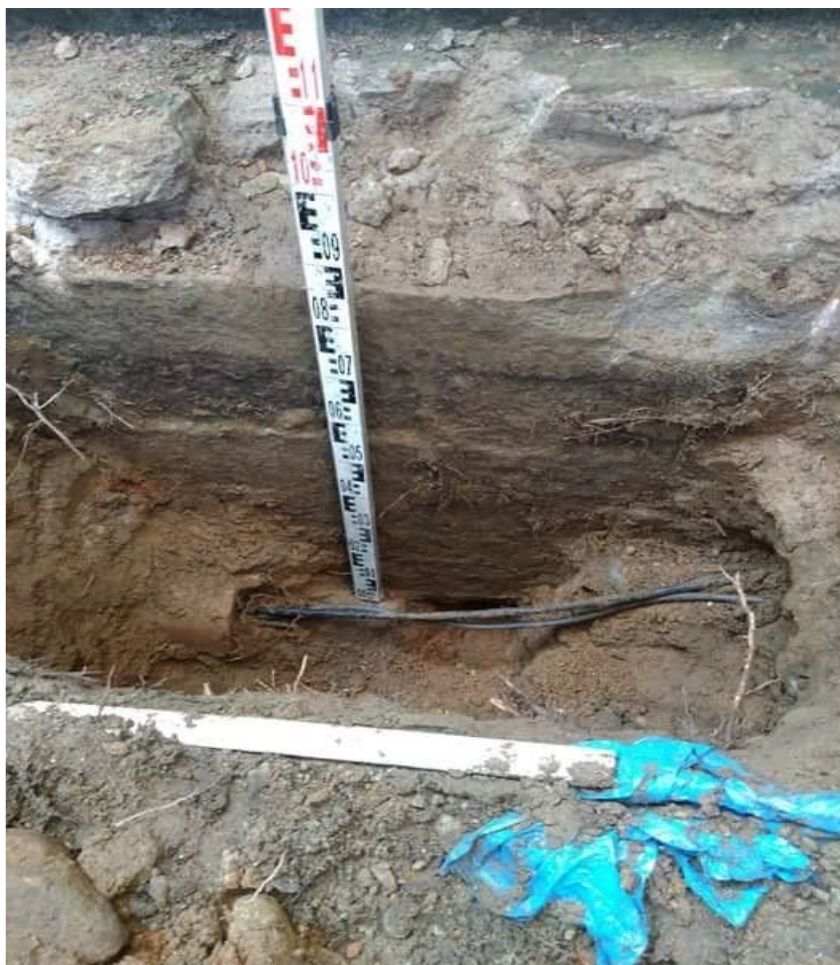
Zdj. 5.4 Odkrywka fundamentowa ściany zewnętrznej części niepodpiwniczonej
