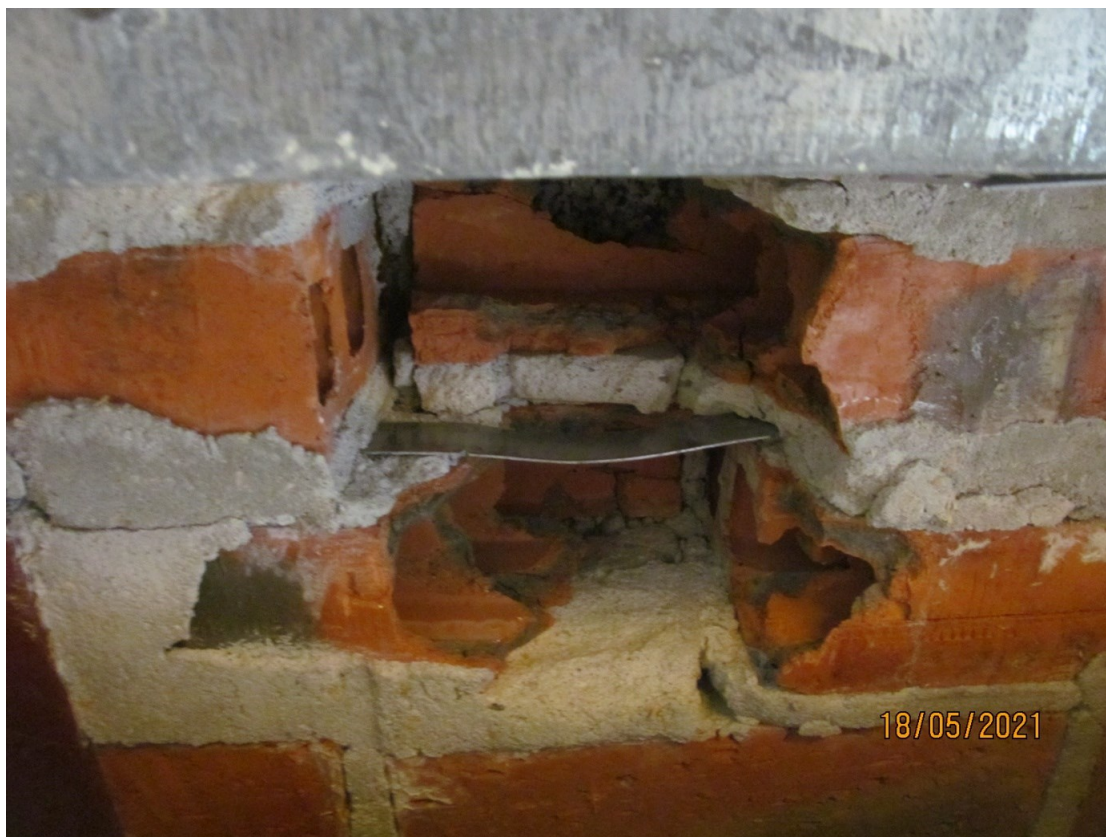
Zdj. 5.14 Odkrywka stropowa 2/3, widoczna zbrojenie z bednarki
