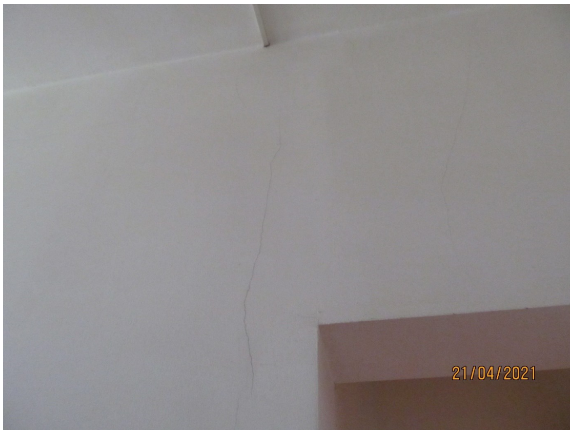
Zdj. 5.8 Zarysowanie ściany wewnętrznej
