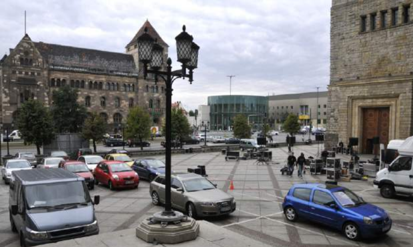
Montaż instalacji dźwiękowej i świetlnej, 19 września 2008
