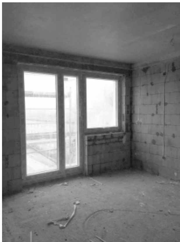
5. Wnętrza mieszkania w trakcie budowy - zdjęcia własne z 24.04.2017 r.
