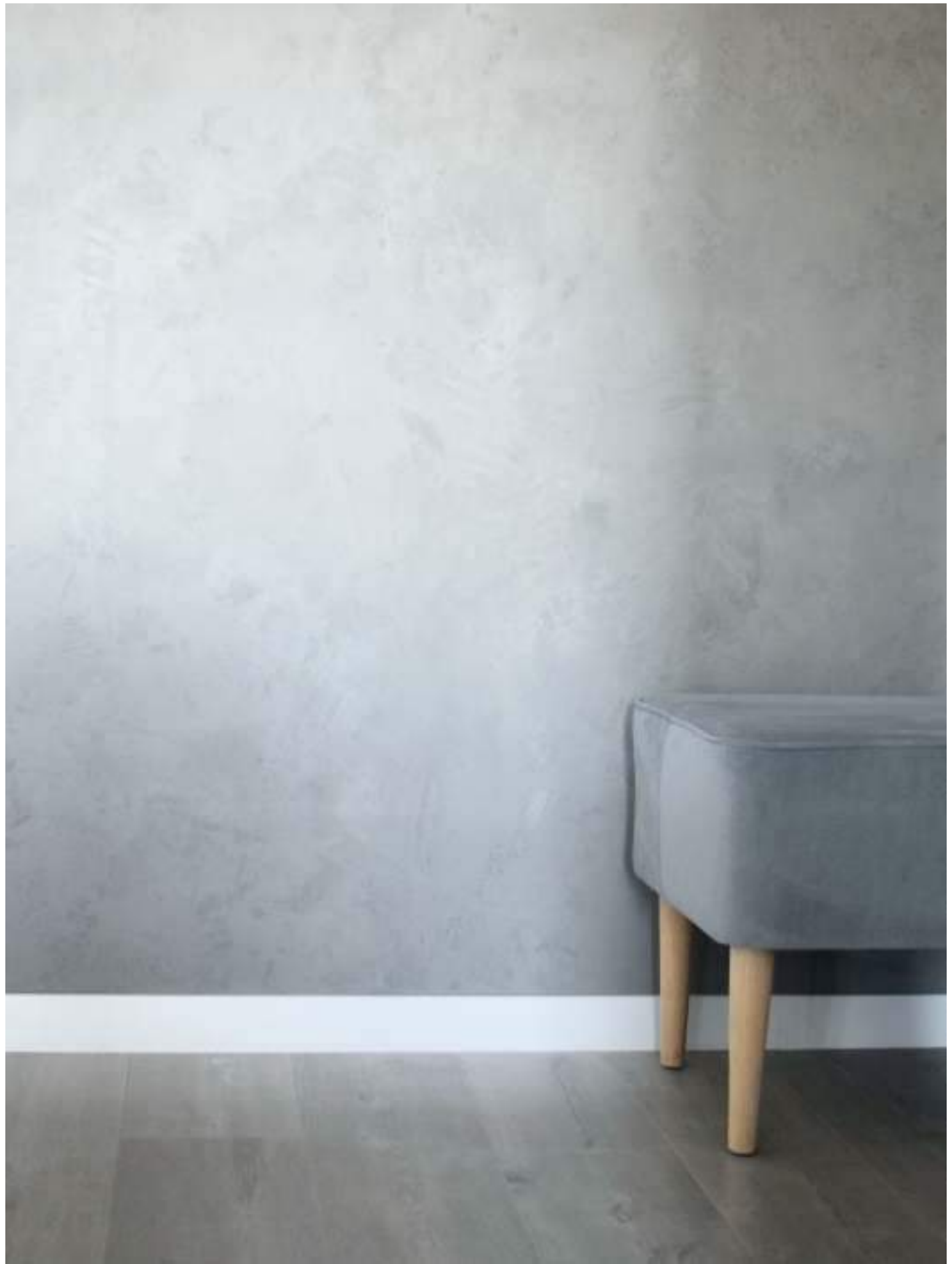
10. Ściana w hallu - detal ściana z betonu architektonicznego.
